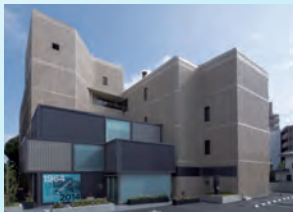
3代目施設 2014年10月～ Photo:UESUGI Akira
