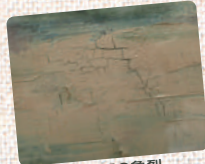
絵具層の亀裂
