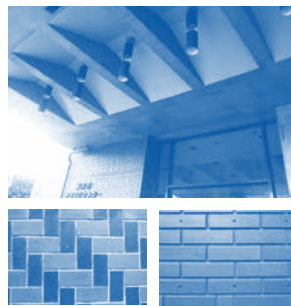
上：建物正面の天井 左下：エントランスロビーの床 右下：外装
