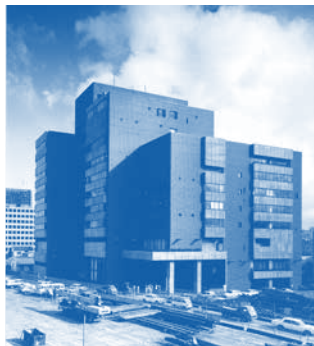
横浜市教育文化センター（1974年竣工当時） 写真提供：新建築社 協力：前川建築設計事務所
