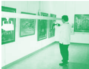
バトン*1を下ろして照明器具を取り付けているところ
